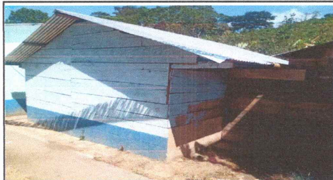
Foto: 3 Sustitucion de madera por block, en una aula, asi como el cambio de techo.
