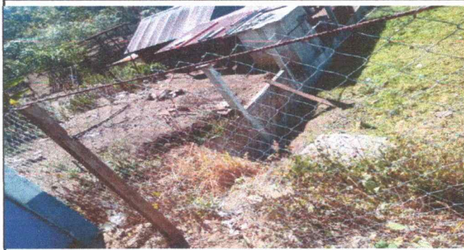
Foto:1 Muro perimetral, sustitucion de malla por block
